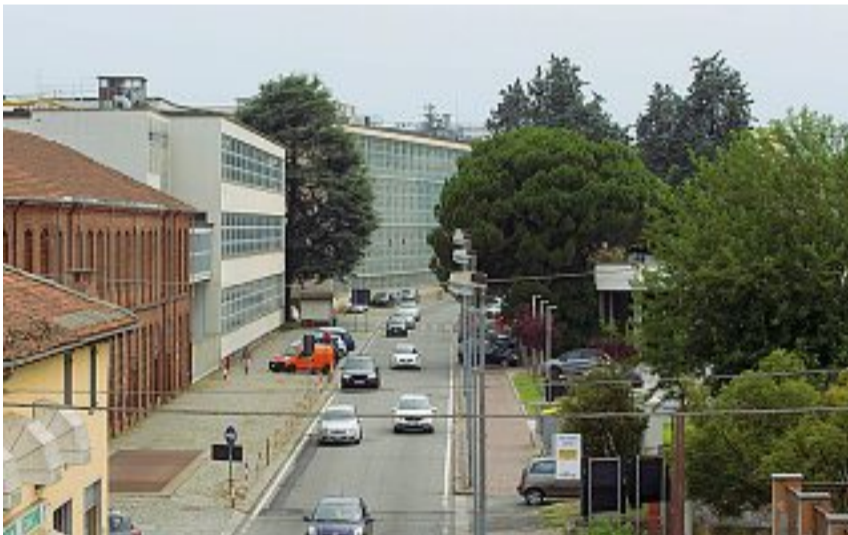
Città Via Jervis a Ivrea, con sulla sinistra la fabbrica di mattoni rossi e gli uffici di Vodafone
