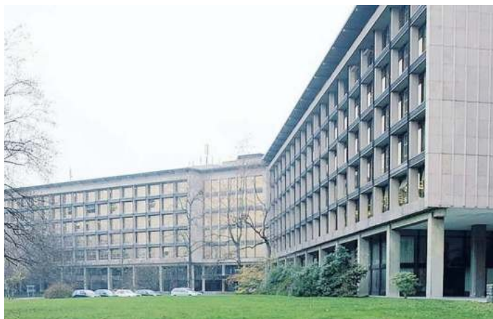
Il Palazzo Uffici Olivetti, realizzato nei primi anni 60 dagli architetti Fiocchi, Bernasconi e Nizzoli
